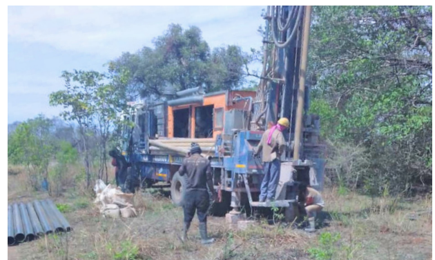
Beginn der Bohr- und Brunnenarbeiten in Kasamba
